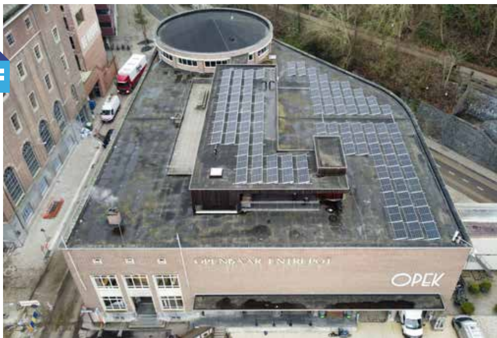
▲ Op het dak van OPEK liggen sinds dit jaar 110 zonnepanelen.
