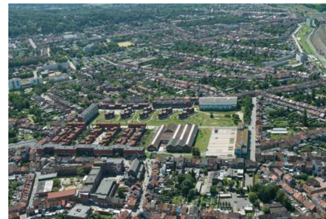
Centrale werkplaatsen © Henderyckx
