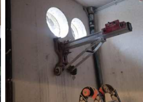
Gaten voor de koelingsinstallatie De Girafant
